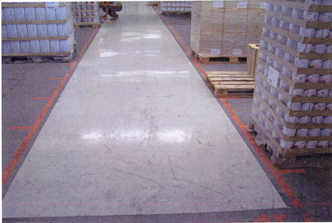
Bild 4: Beschichtungsfläche nach 2-jähriger Nutzung
