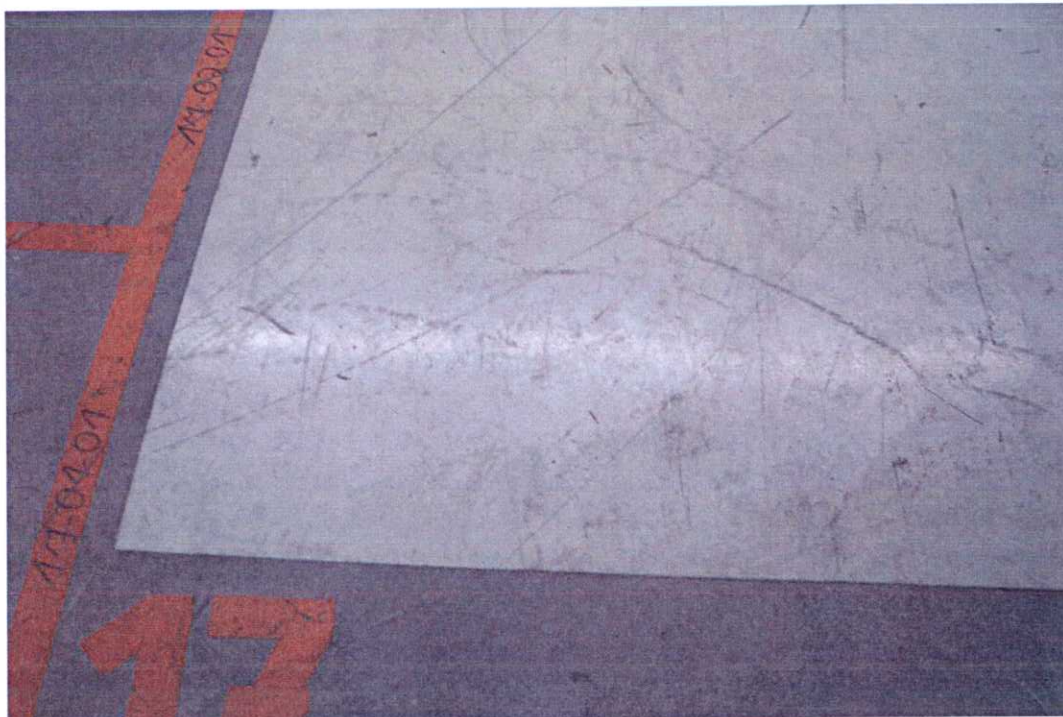
Bild 5: Detailbild - Beschichtungsfläche nach 2-jähriger Nutzung Die dunklen Stellen markieren Abrieb von Handhubwagen- und Gabelstaplerreifen.
