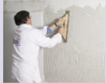
Vollflächiges Aufziehen von Remmers Ansetzmörtel SLP und Aufzählen
