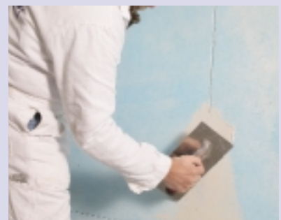
Spachteln der Plattenstöße mit Remmers Schimmel-Sanierspachtel
